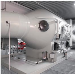
L'aria di scarico viene aspirata direttamente sopra la vasca e depurata dal depuratore d'aria. L'energia termica presente viene recuperata.
